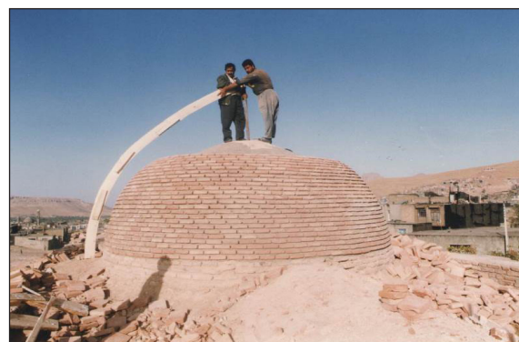
تصویر ۲۰. پوشش آجر گنبد مقبره و کنترل آن با قالب دور قوس (عکس از: نویسنده).
