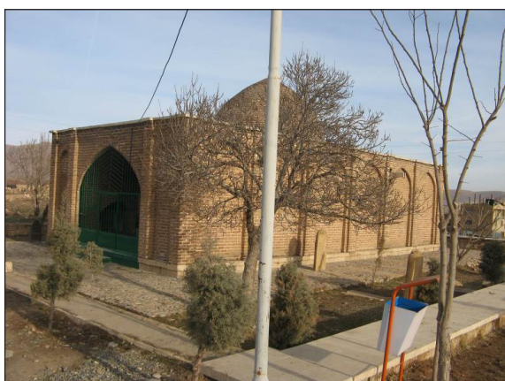
تصویر ۲۲. نصب در فلزی موقت برای ورودی و ایجاد مسیر بازدید مناسب از میان قبرستان قدیمی (عکس از: نویسنده).
