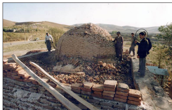
تصویر ۱۹. مرمت اساسی گنبد شبستان به منظور آماده‌سازی برای آجر فرش نهایی (شادروان سیدشفیع حسینی رئیس وقت اداره مهاباد که با دایره مشخص شده در تصویر دیده می‌شود) (عکس از: نویسنده).
