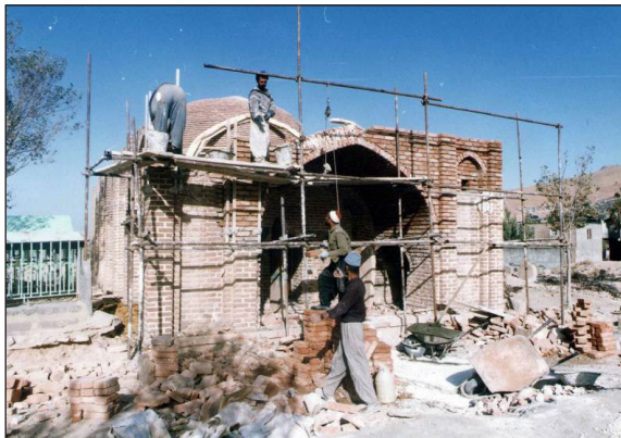
تصویر ۱۸. شمعی‌بندی و تهیه مصالح و بازسازی ایوان جنوبی (عکس از: نویسنده).
