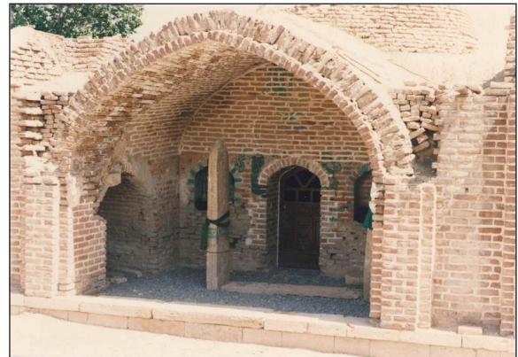
تصویر ۱۷. آماده‌سازی ایوان جنوبی مطابق طرح بازسازی بخش‌های فروریخته (عکس از: نویسنده).
